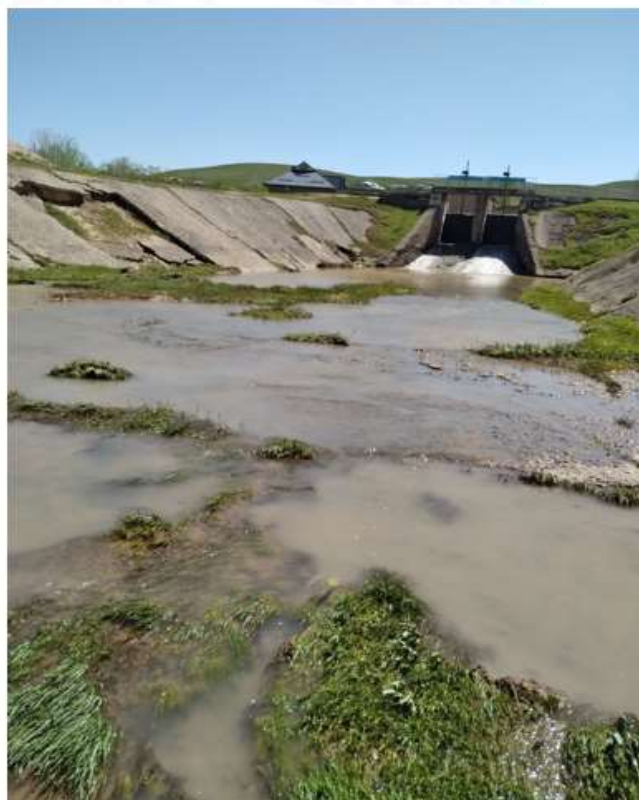
2-rasm: Qumdaryo kanalning PK7+80 da joylashgan Qumdaryo daryosiga sel suvlarini tashlovchi Qumdaryo tashlama inshootini bugungi kundagi holati
