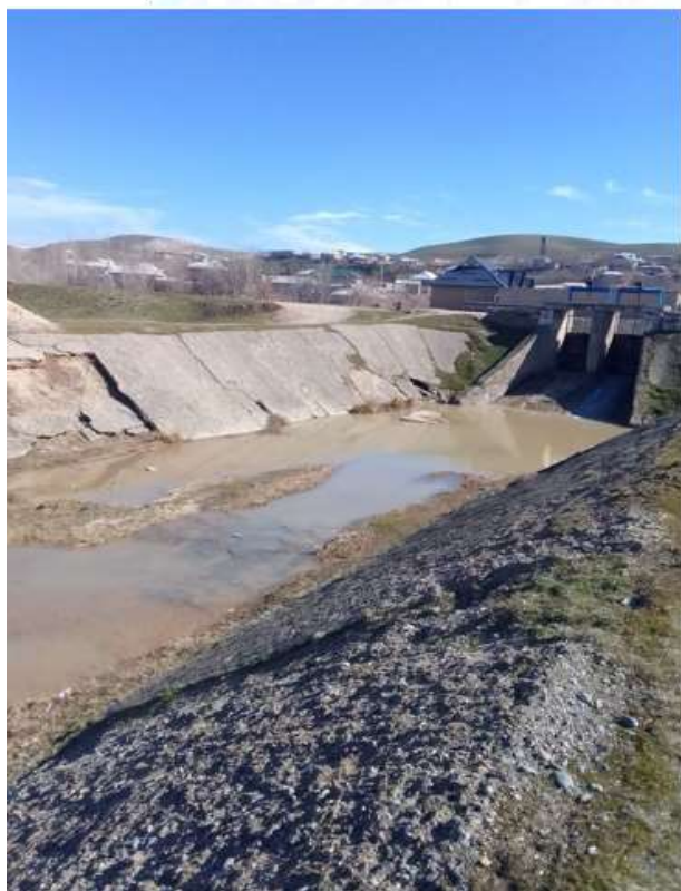
2-rasm: Qumdaryo kanalning PK7+80 da joylashgan Qumdaryo daryosiga sel suvlarini tashlovchi Qumdaryo tashlama inshootini bugungi kundagi holati
